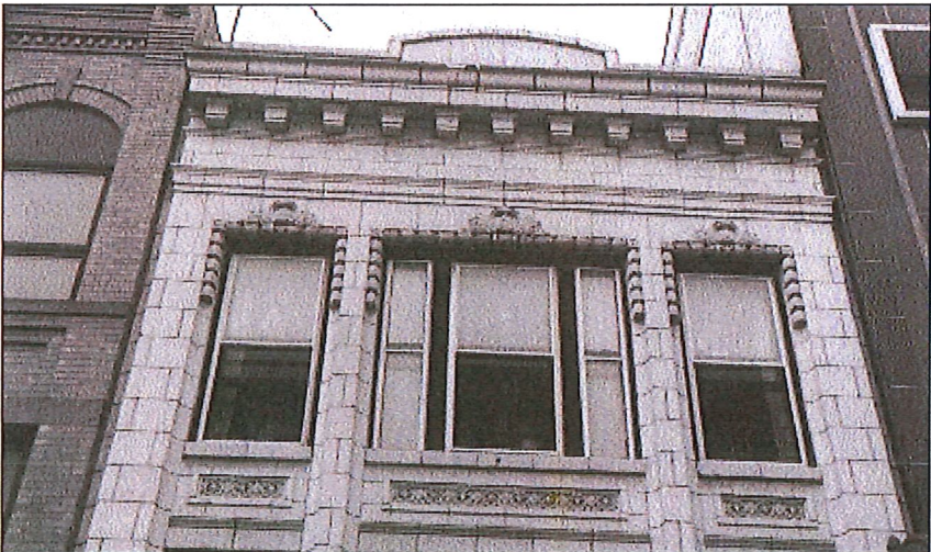
Glazed masonry (terra-cotta) cornice
